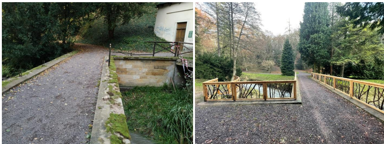
Mostek mezi horním a spodním rybníkem – demontáž zábradlí Stejný mostek s novým zábradlím
