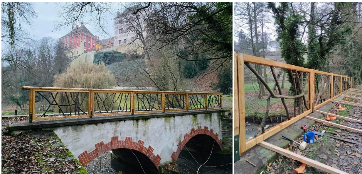
Montáž nového zábradlí na mostku před horním rybníkem
