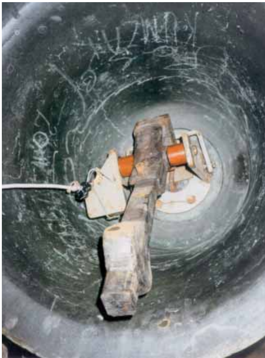
Obr. 5. Zvon z roku 1534 umístěný v kostele sv. Jiří v Božejově (okres Pelhřimov). Pohled dovnitř zvonu. Nevhodné srdce se sníženou osou otáčení, s protizávažím a zkrácenou výpustí a s přídavnou elektromagnetickou aretací srdce.
