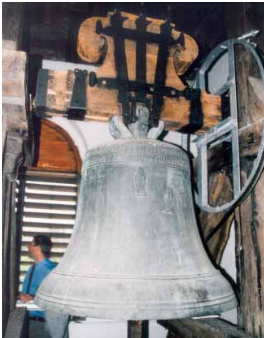
Obr. 6. Zvon z roku 1505 umístěný ve zvonici u kostela sv. Pankráče v Praze-Nuslích. Jeho průměr činí 103,5 cm, hmotnost je přibližně 700 kg. Při instalaci pohonu elektromotorem v roce 2003 nedošlo kromě zbytečné výměny závěsných železných pásů přitahujících zvon k hlavě a výměny ložisek k zásahům do zvonové soustavy. Zavedení elektrického pohonu je však v tomto případě z hlediska památkové péče zcela nevhodné.
