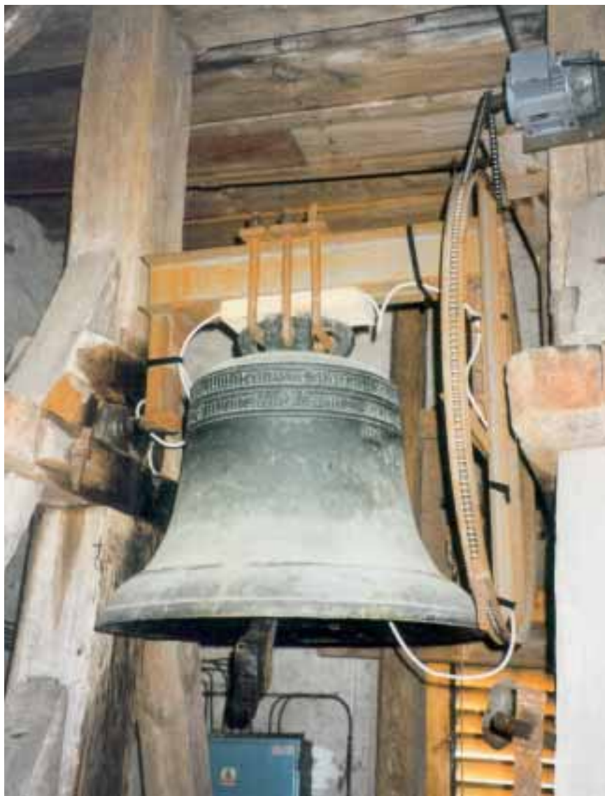
Obr. 4. Zvon z roku 1534 umístěný v kostele sv. Jiří v Božejově (okres Pelhřimov). Nepřípustná úprava na pohon elektromotorem z poloviny 90. let 20. století. Dobře jsou vidět nežádoucí a nebezpečné zásahy: zavěšení na lomeném závěsu svařeném z ocelových nosníků, zkrácená výpusť srdce, vedení elektrického proudu dráty volně v prostoru a přes okraj dovnitř do zvonu.
