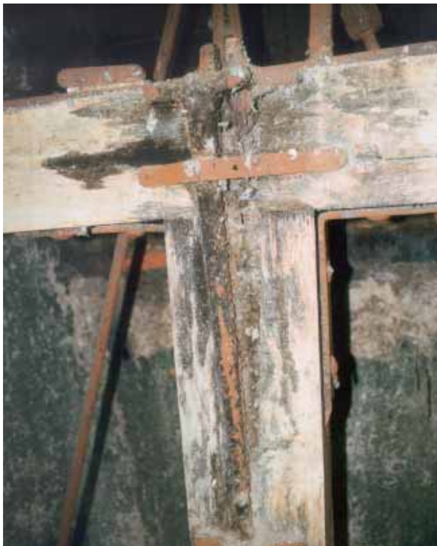
Obr. 8. Dřevěná zvonová stolice a takzvané rohatiny v severní věži kostela sv. Jana Nepomuckého na Skalce v Praze na Novém Městě. Zbytek uložení čepů závěsu zvonu na rohatinách. Jedná se o systém používaný v Čechách od 17. století, na obrázku je však soustava z mladší doby (pro dva ze tří zvonů zhotovených roku 1897 v dílně Grassmayrů v rakouském Innsbrucku). V pohledu ze strany je dobře vidět samotná železná rohatina nesoucí čep závěsu zvonu a vodorovný pásek omezující její pohyb.
