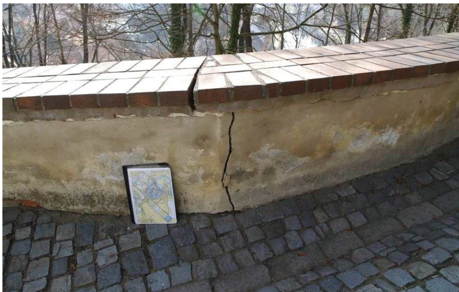
Obr. 6.1.4 Lokalita „K Zámecké zahradě“ - deformace římsy
