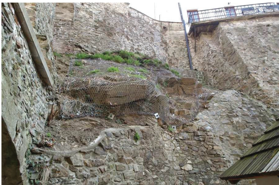
Obr. 6.1.8 Lokalita „Myší díra“ - skalní řícení a opadávání strmých stěn skalního masivu
